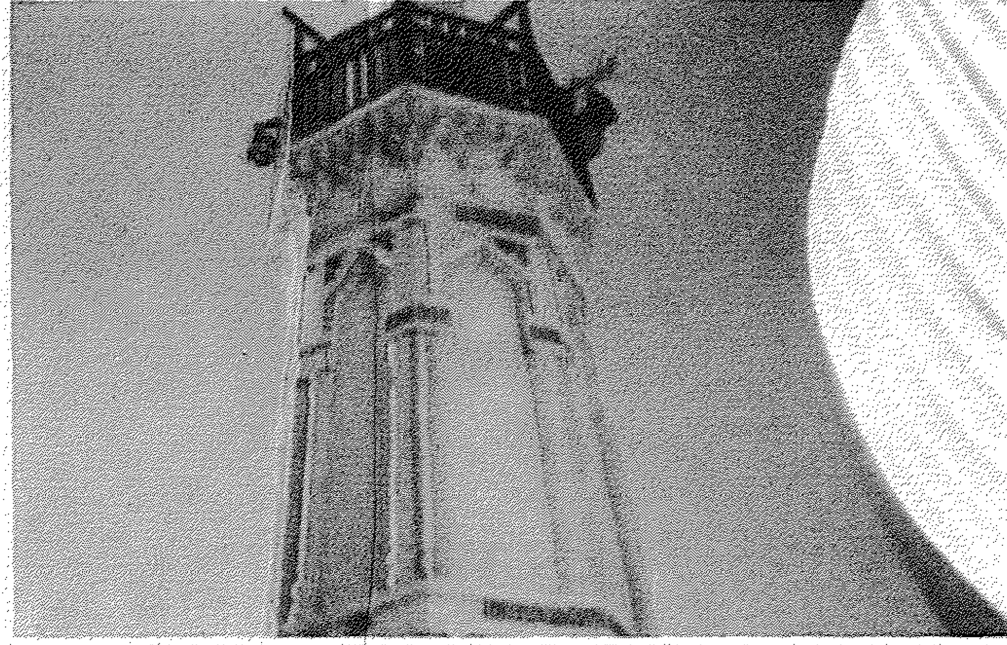
لوحة رقم ( ٣٠ ) : المستوى الثاني من البدن المثلثن لمتذنة مسجد العباسي برشيد وتظهر المقرنصات وشرفة الأذان
